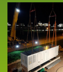
Anhebung ISO Power House mit Mobilkran
